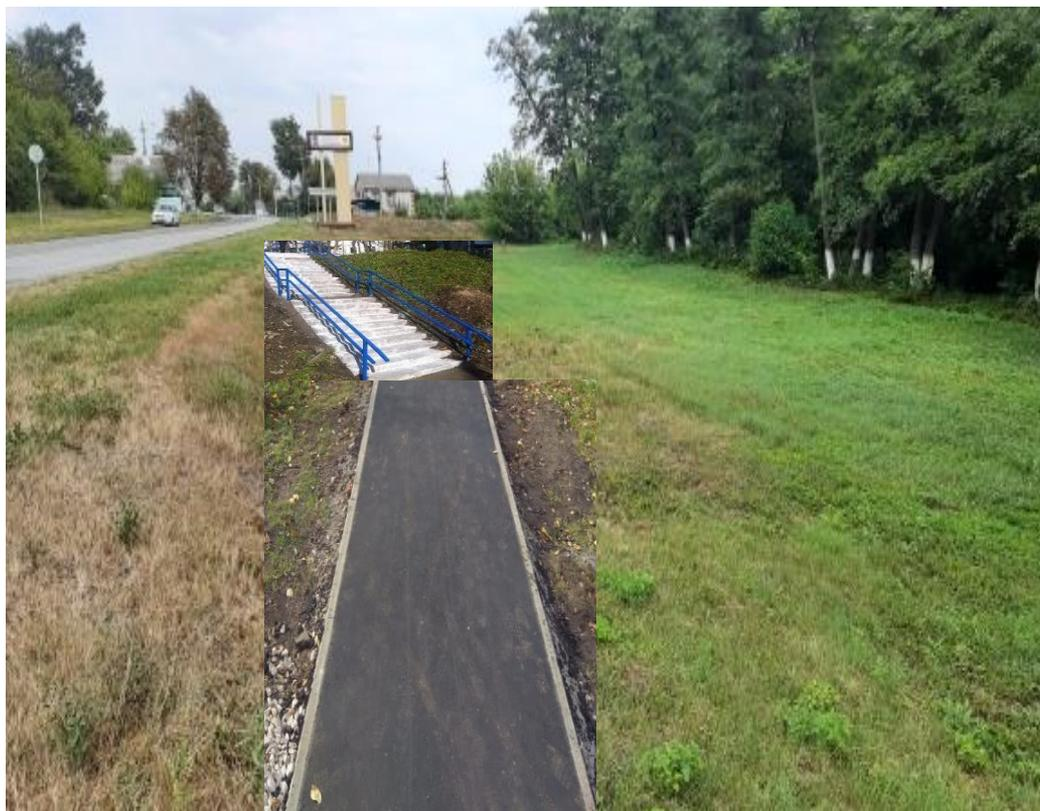
Обустройство тротуара в асфальтобетоне, с обустройством бордюра, щебневого основания и земляной отсыпкой протяженностью – 1030 м., шириной – 1,2 м
