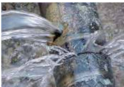
Рис. 4.30. Потери воды на магистральном водопроводе
