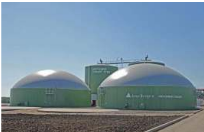
Рис. 4.14. Биогазовая станция «Лучки»
