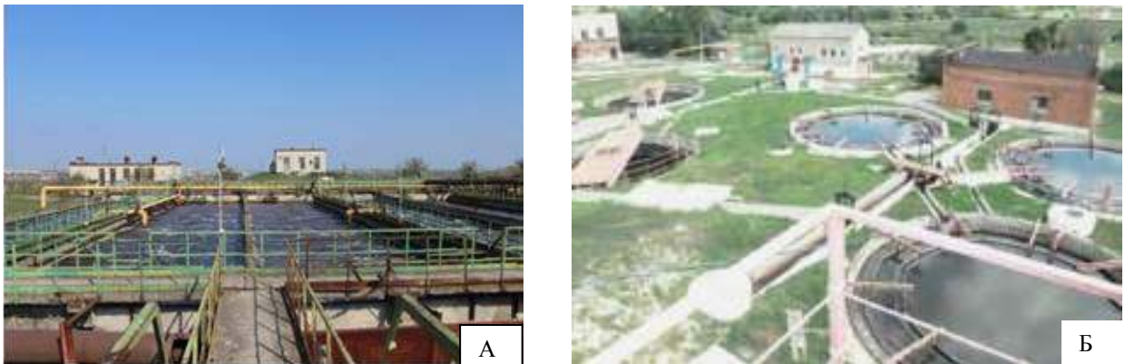
Рис. 4.33. Очистные сооружения: А - Аэротенк в г. Губкине, Б - МУП Водоканал г. Валуйки
